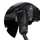
Batería conectada al controlador
