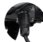
Batterij aangesloten op controller
